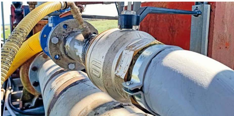
**Foto 4** Il digestato microfiltrato è stato miscelato alle acque di irrigazione per mezzo di una nuova tubazione innestata sulla condotta di aspirazione dell'acqua, e dotata di valvola di apertura/chiusura, tubetto di scarico dell'aria, contaltri
